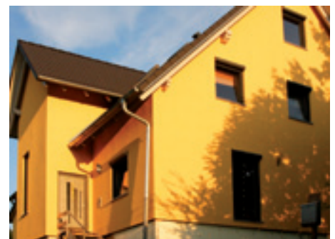
Gedämmt und fertig verputzte Fassade
