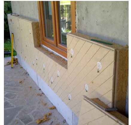
Zuschneid Fensteraussparung und Laibung
