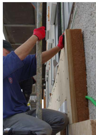
Kabelschläuche sicher verbergen
