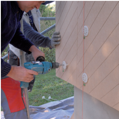
Der Stelldübel befestigt und justiert das Dämmelement zugleich
