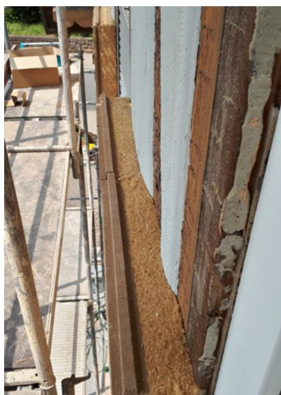
Fachwerkfassaden überdämmen
