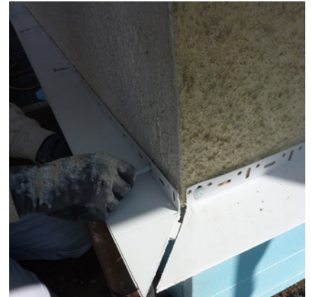
Montage UdiBASE® Wandanschlussprofil
