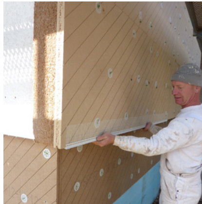
Nach Justierung UdiBASE® Aufsteckprofil aufstecken
