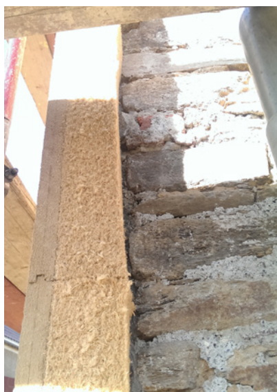
Krumme Wände ausrichten
