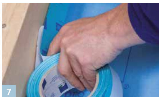
UNI TAPE Universele kleefband het verlijmen van de baanoverlappen
