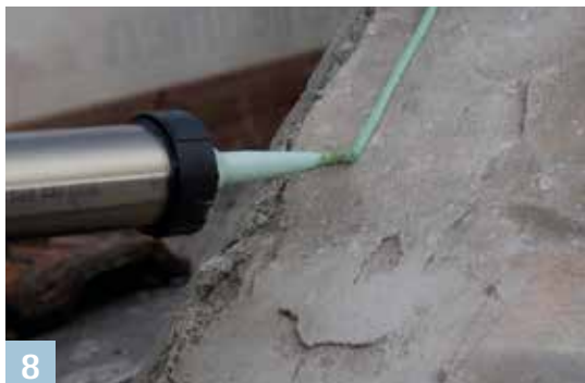
ORCON F Allround-aansluitlijm in patroon of buisfolie Voor verbindingen met aangrenzende minerale of ruwe bouwelementen
