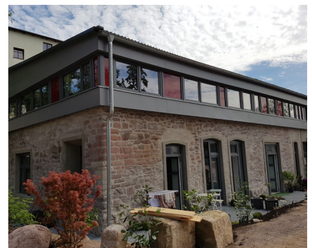
Außenansicht nach Fertigstellung
