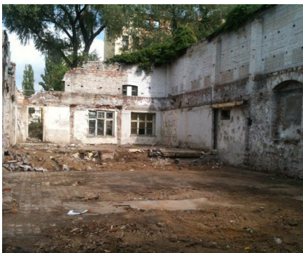
Ruine vor dem Aufbau
