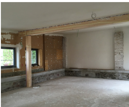
UdiSUN® im Deckenbereich verspachtelt
