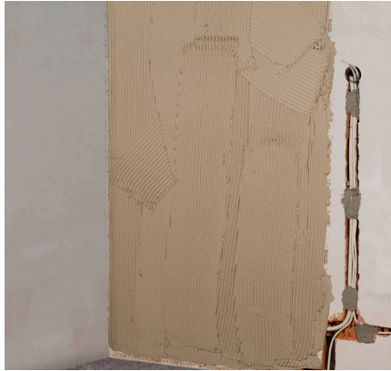
2. Einspachteln und verbinden
