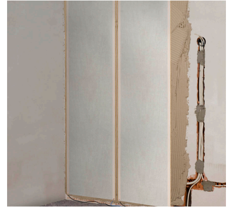
3. Fertig montiert für die Oberflächenbeschichtung
